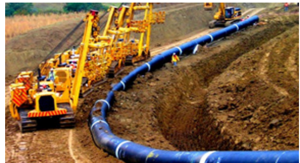
شکل ۱ خط لوله مدفون انتقال گاز.
