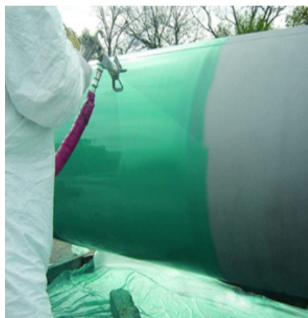
شکل ۵ اعمال پاششی پوشش پلی‌اوره بر لوله فولادی.
