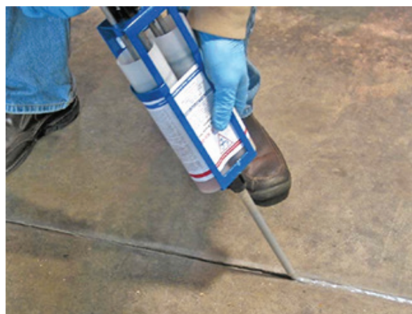
شکل ۷ سامانه درزگیری با پلی‌اوره
