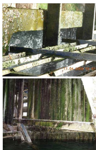
شکل ۷ مواردی از رشد جلبک در مخزن انتهایی برج‌های خنک‌کننده نیروگاه‌ها [۱۲].
